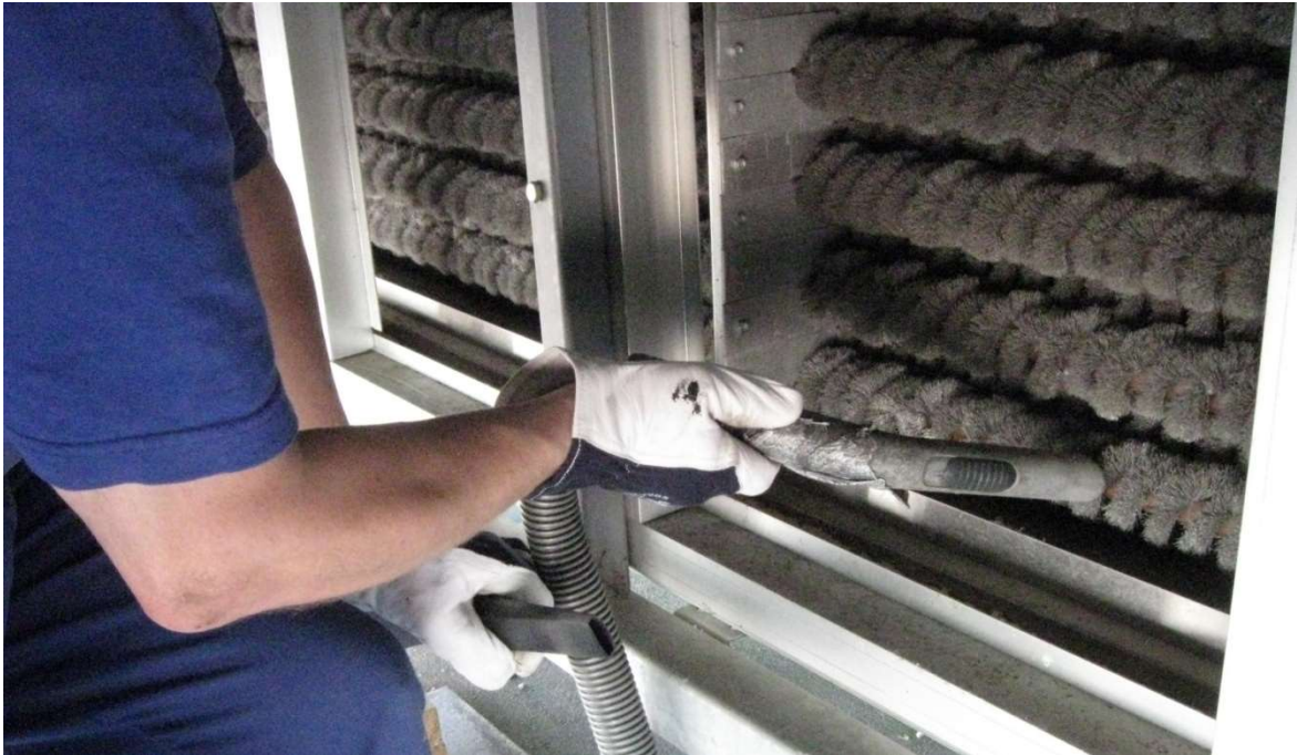
Kuva 1: Harjapatterin puhdistus, imurointi
