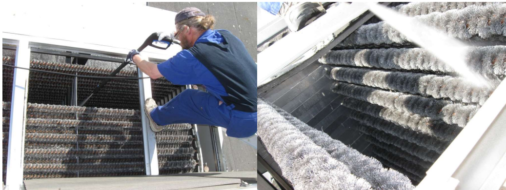
Kuva 2: Harjapatterin puhdistus, painepesu
